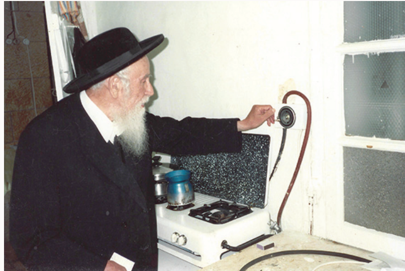
מרן הגר"מ פיינשטיין זצ"ל בבדיקת ה'גומ' (לכינוי הג'מ באופן אוטומטי ביו"ט) שהותקן בביתו ע"י המכון המדעי טכנולוגי להלכה
